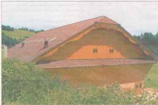
Scheune mit Steildach – mit Eternit gedeckt.
