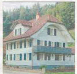
...und nach der Renovation.
