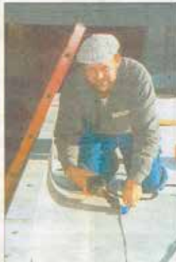
Arbeit an Abdichtungsbahnen auf dem Flachdach.
