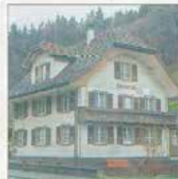
Ansicht einer Fassade vor der Renovation...
