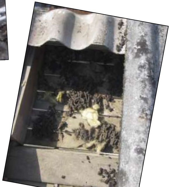
das Telefon klingelt im Büro Menznau „guten Tag, ich habe ein Problem, bei meinem Dach dringt Wasser aus der Untersicht! können sie ihren Reparaturdienst vorbeischieken? „ prompt wie wir sind, haben wir gleich Beat vorbeige- schickt, dieser staunt nicht schlecht als sich die rin- nende Untersicht als Marder WC entpuppt!!
