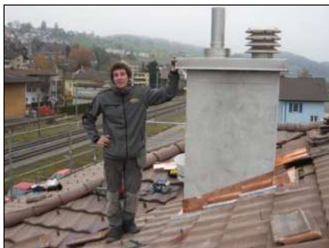
Stefan's 1. Kamineinfassung, die er selber gemessen, gerüstet und montiert hat!
