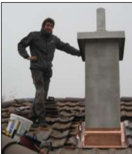
Stefan's 1. Kamineinfassung, die er selber gemessen, gerüstet und montiert hat!
