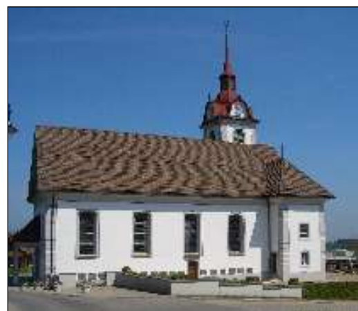
Kirche Menzberg Unterhalts- & und Blitzschutzarbeiten
