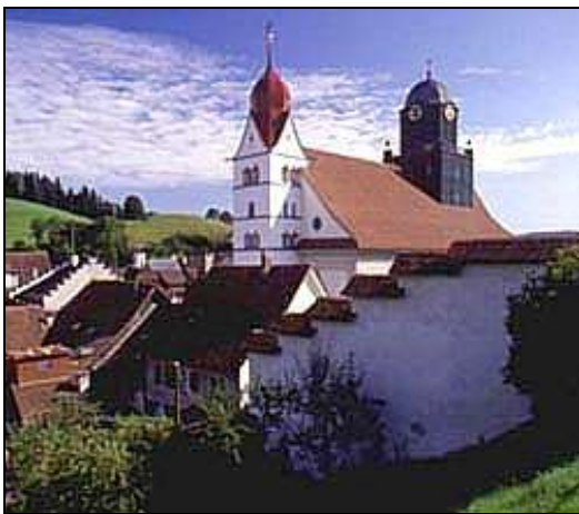
Kirche Peter & Paul in Willisau Reparaturarbeiten
