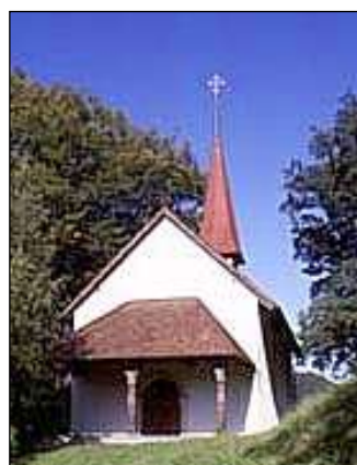
Kapelle St. Niklausen in Willisau Turmsanierung mit Holzschindeln (Nov. 2009)
