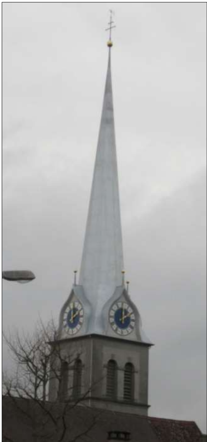
Kirche Reiden Turmrenovation mit Blechschindeln
