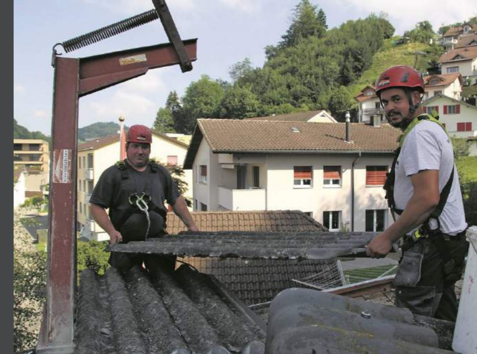
Auf das Unwetter folgt die Arbeitsflut: Philipp Zemp (links) und Christian Häfliger (rechts) beim wechseln von defekten Eternitplatten eines Einfamilienhauses in Wolhusen.
